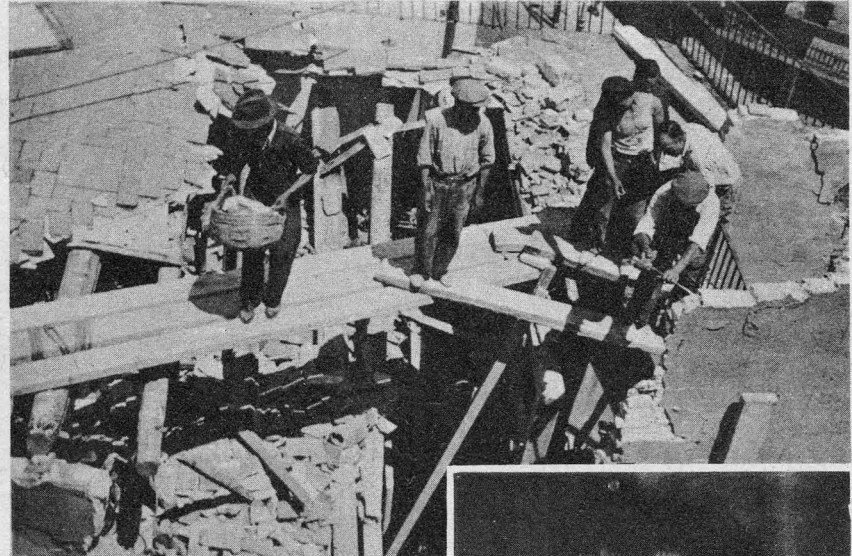
Efectos de uno de los recientes bombardeos aéreos efectuados sobre Valencia.
